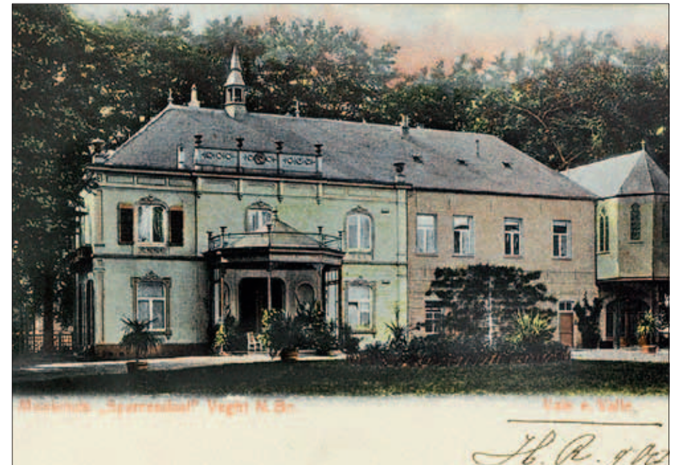
Sparrendaal bleek aan het eind van de negentiende eeuw een ideale behuizing voor de Missionarissen van Scheut. Bij deze opname van de achterzijde van het gebouw is de later bijgebouwde kapel goed zichtbaar. (afbeelding internet)
